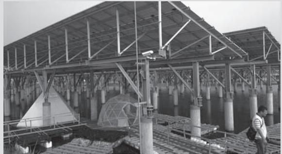
\*「養水種電」係指在廢棄魚塢、鹽化過重的廢田上架高太陽能板。「養水」是讓土地修養復育、水池變成生態養殖區，讓當初超抽的地下水可以慢慢流回土地，「種電」是設置太陽能板，將儲存的電賣給台電。
